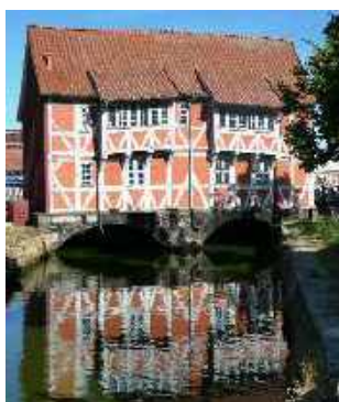
Gewölbe über der Grube
