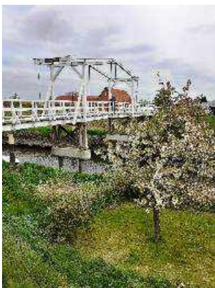
Hogendiek-Klappbrücke über die Lühe
