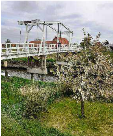
„Hogendiekbrück“ über die Lühe
