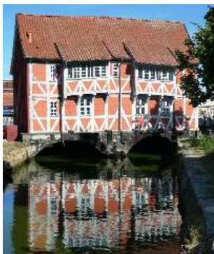
Gewölbe über der Grube
