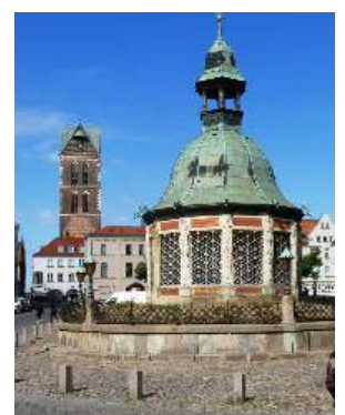
Brunnenhaus, Turm Marienkirche
