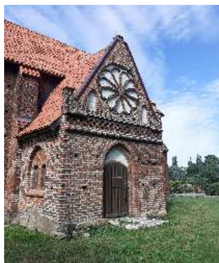
südlicher Anbau mit gotischer Rosette
